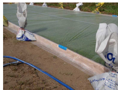
【砂床の上にビニールシートと木枠でプールを作成】
