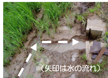
【溝の末端を排水口に接続した状態】
