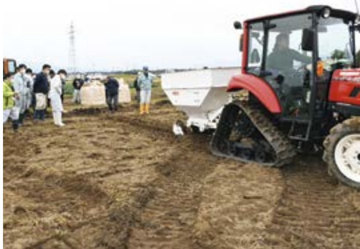
モミサブローを使ったもみ殻補助暗きよの施工風景を見学する参加者。
