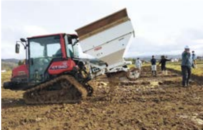
専用機「モミサブロー」による補助暗きょ施工の様子。
