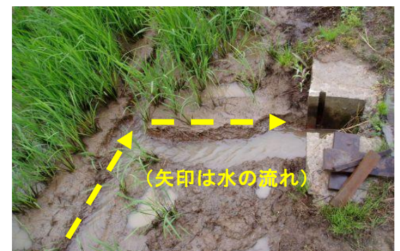
【溝の末端を排水口に接続した状態】
